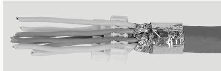
7. Adern an der Aderanlegekappe mit einem Seitenschneider bündig abschneiden
