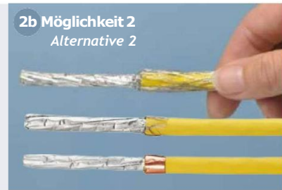
2b Möglichkeit 2 Alternative 2 Schirmgeflecht zurückschieben, auf 5 mm kürzen und mit selbstklebender Kupferfolie fixieren. Push back the copper braid, cut it to 5 mm and fix it with self-adhesive copper foil.
