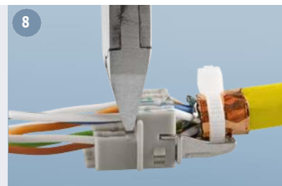
8 Adern bündig am Adernsortierer abschneiden. Trim wires flush with the cable sorter.
