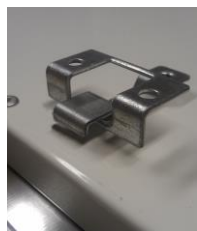
Detail eingehängte Deckenhalter
