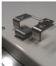
Detail eingehängte Deckenhalter
