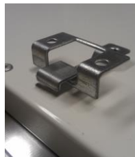
Detail eingehängte Deckenhalter
